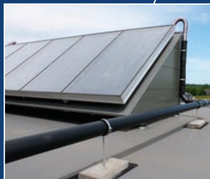
De lige rør leveres i h.h.v. 5 meter for kobberør og 6 meter for el-forzinkede stålør
