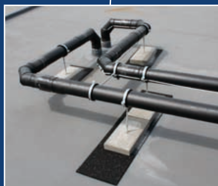
De mange daglige bevægelser optages i de dertil konstruerede bøjninger, ligesom rørbøjningerne er med til at optage kræfterne.
