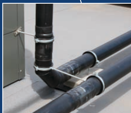
Rørene samles med Gerberit/Mapress koblinger omsluttet af PUR halvskåle og forseglet 100% med krympbare muffer
